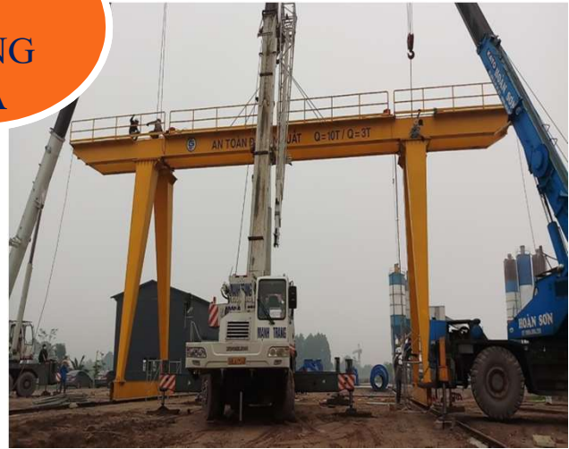
Công trục dầm đôi
