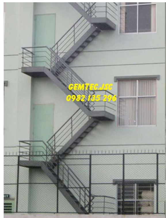
CẦU THANG THOÁT HIỂM
